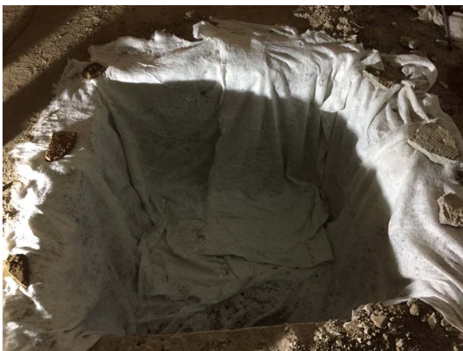
Foto 38: Cobriment amb geotèxtil de les estructures de la cala 7.
