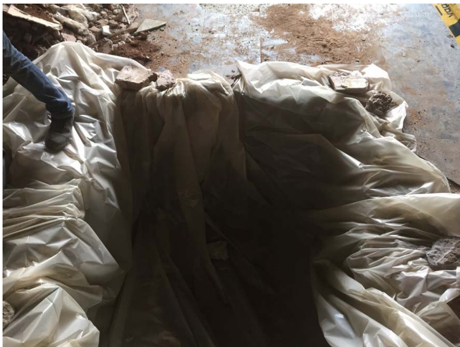
Foto 33: Protecció estructures cala 6 amb geotèxtil i plàstics.
