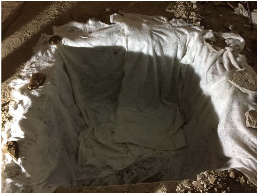
Foto 50: Cobriment amb geotèxtil de les estructures de la cala 10.
