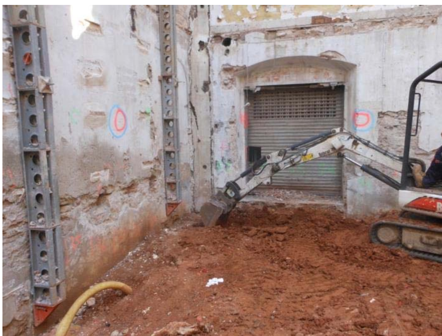
Fotografia 85: Control arqueològic del rebaixos amb màquina retroexcavadora.
