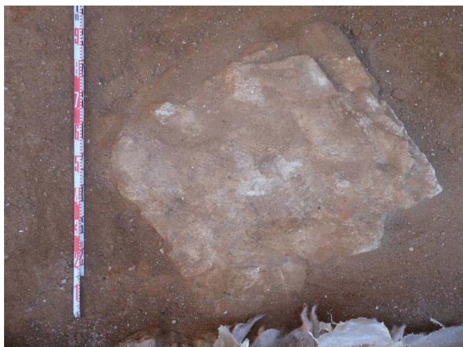
Fotografia 95: Vista de detall del basament de pilar UE 616.
