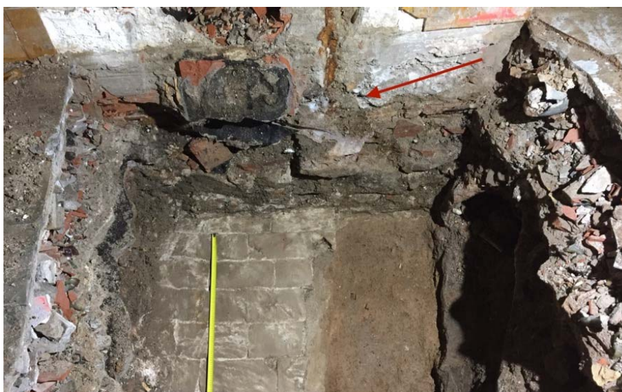
Foto 52: Mur segle XIX UE 4010.
