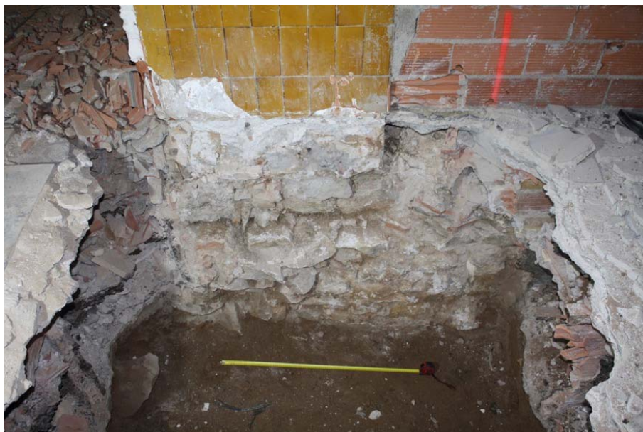
Foto 45: Fonamentació del mur UE 3006.
