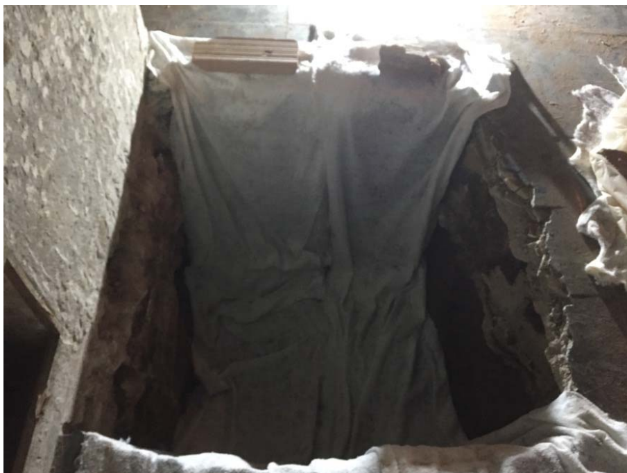
Foto 23: Protecció estructures cala 4 amb geotèxtil i plàstics.
