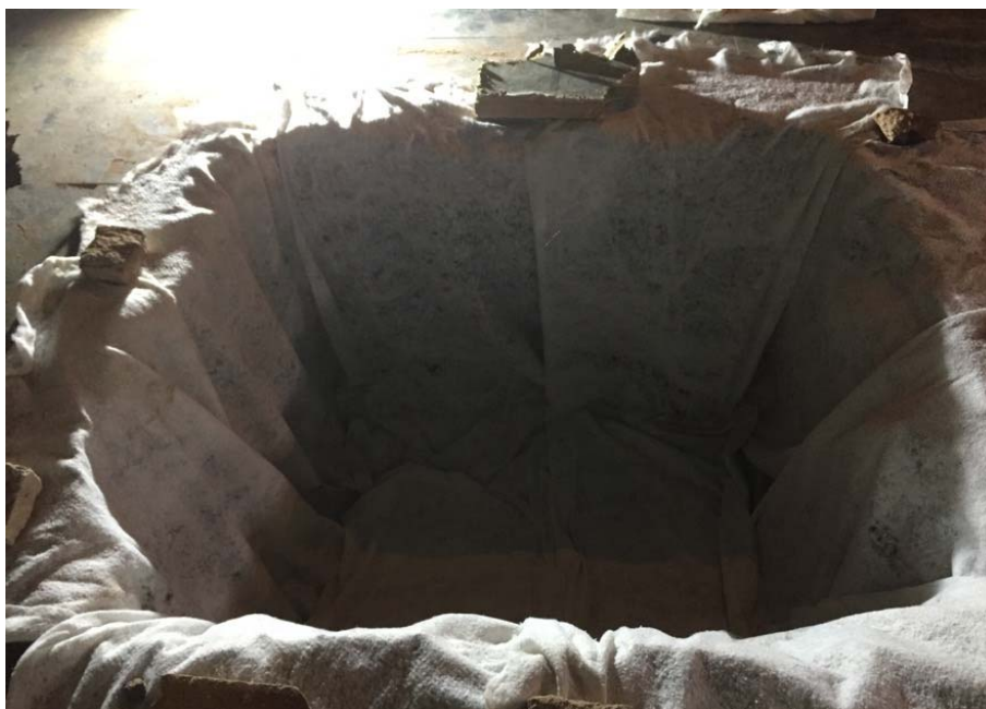
Foto 12: Protecció estructures cala 2 amb geotèxtil.
