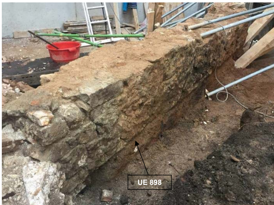
Fotografia 104: Vista del mur a la part més septentrional del mur UE 898 que formaria part del límit de ponent del convent de Valldonzella a la segona meitat del segle XVII.
