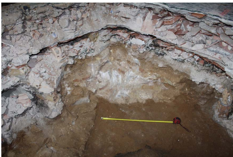
Foto 8: Vista de l'alçat del mur UE 1005, parcialment repicat.
