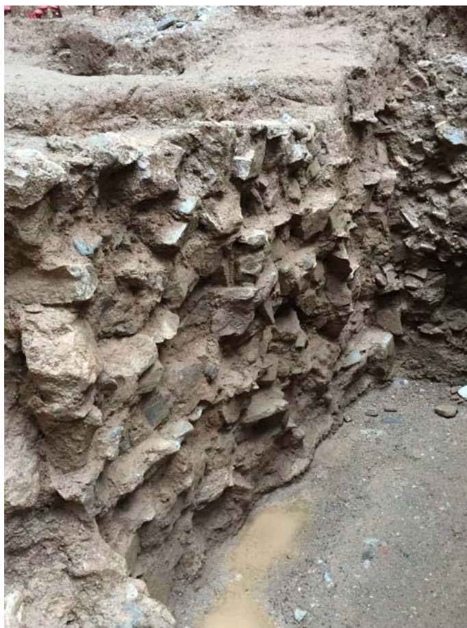
Fotografia 116: Detall de l'alçat del mur UE 858.
