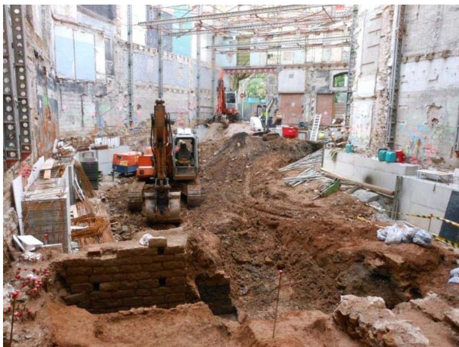
Fotografia 109: Mur UE 773 en el context de l'obra constructiva que s'està realitzant.
