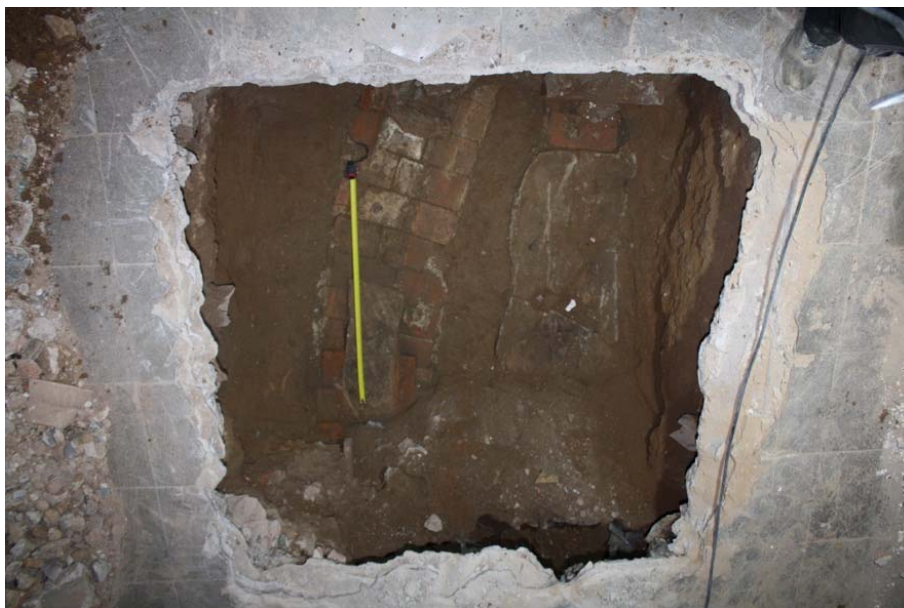
Foto 77: Vista general de la cala 14.
