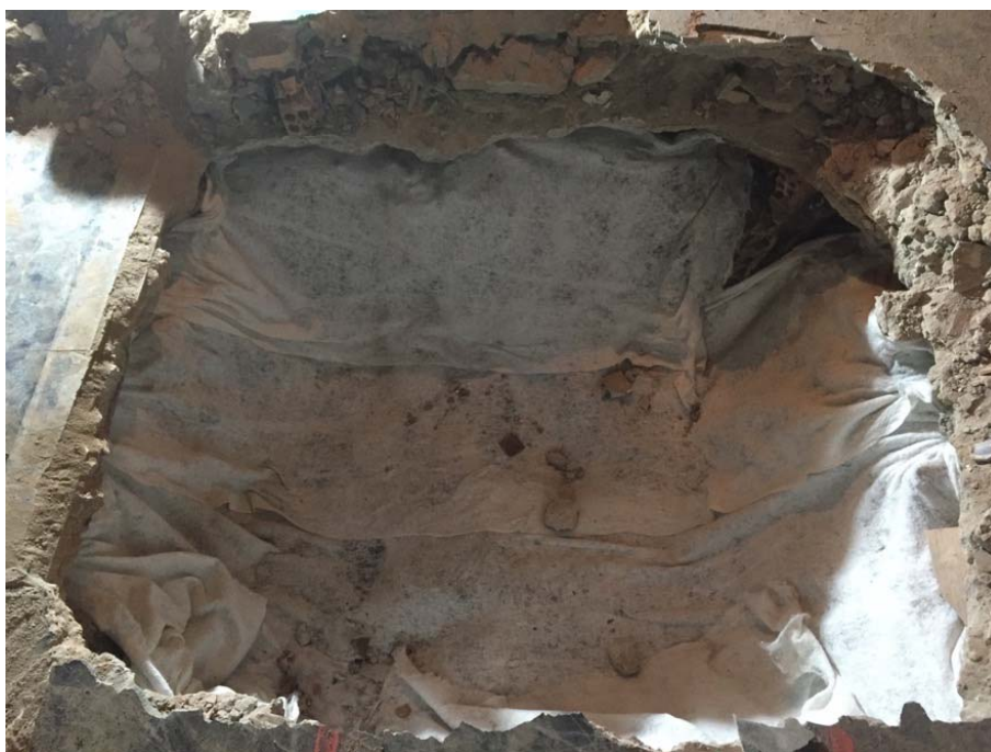
Foto 4: Protecció cala 1 amb geotèxtil.
